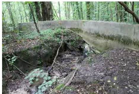
Photo 7 : mur maçonné au milieu du bassin
