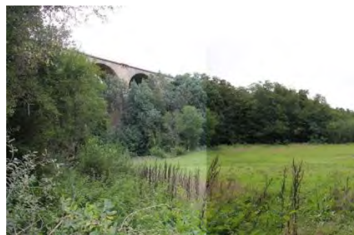
VUE SUR LE VIADUC DEPUIS LE CHEMINEMENT
