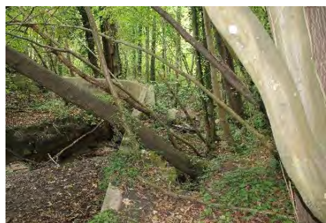
Photo 10 : brèche au nord-ouest
