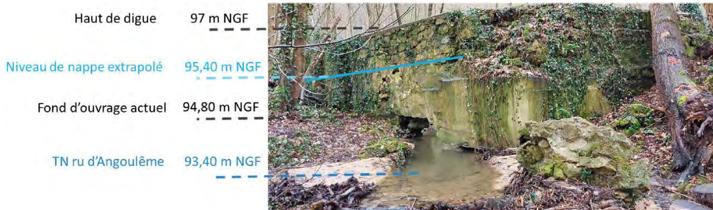
Photo 1 : Vue du ru d'Angoulême en sortie du bassin (vue aval)
