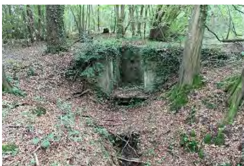
Photo 9 : déversoir d'origine au nord est
